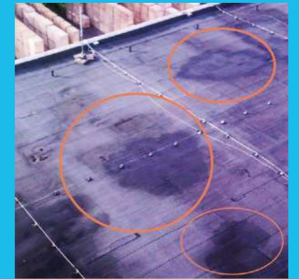
Poškodenie strechy zapríčinené nedostatočným vyspádovaním strechy.
